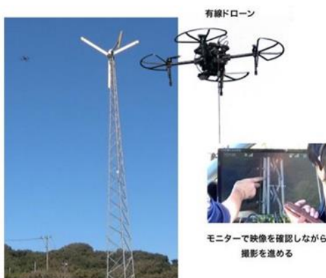
Fig.7 風車ドローン目視点検写真
